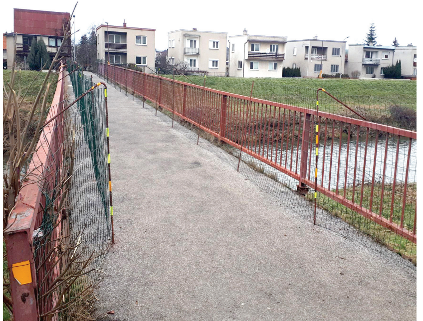
Do rozpočtu na rok 2021 bola zaradená aj rekonštrukcia mostného objektu cez rieku Nitru
