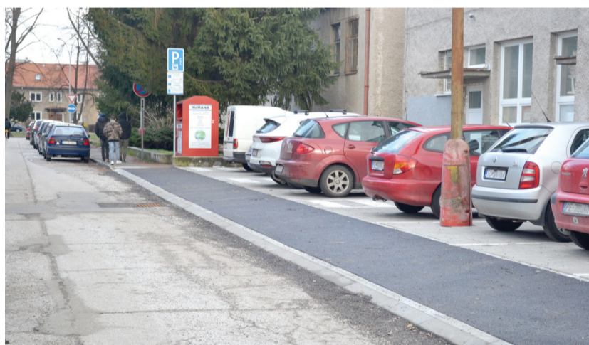
Chodník z asfaltobetónovej zmesi bol zrenovovaný na Strojárskej ulici
