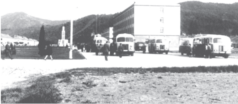
Prvé nástupištia vybudovali v centre mesta
