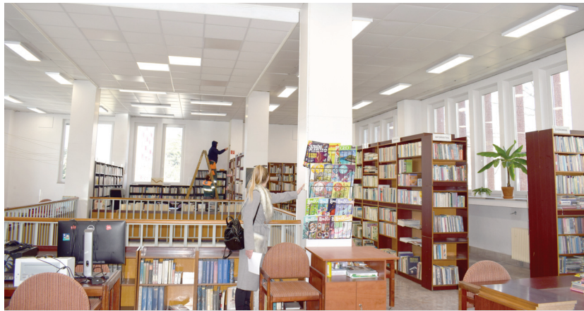
Súčasťou rekonštrukcie elektroinštalácie knižnice bola výmena hliníkovej kabeľáže za medenú
