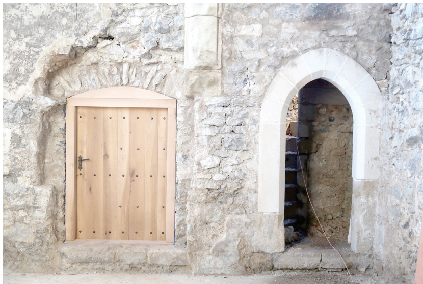
Predmetom prác v kaplnke hradu Beckov bude aj sakristia, nad ktorou sa vybuduje tehlová klenba. Nad ňou vznikne pochôdzne prestrešenie, ktoré v budúcnosti môže slúžiť ako vyhlídková terasa pre verejnosť
