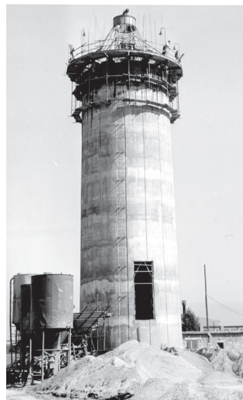
Výstavba komína v areáli ZDA Partizánske Foto: archív redakcie
