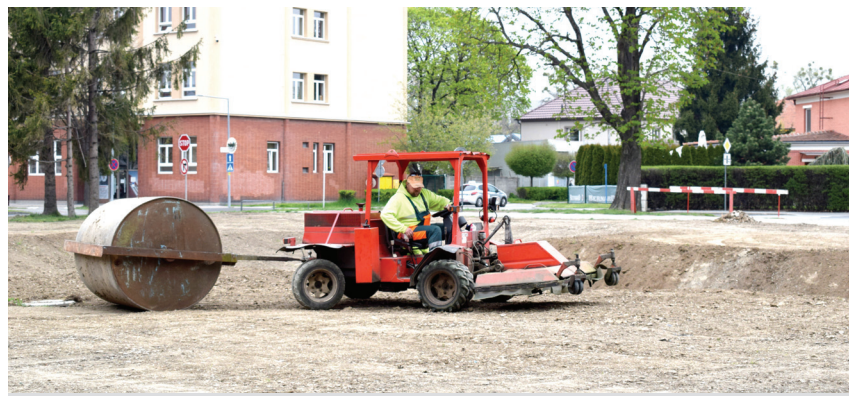
Pôda na priestranstve po asanovanej výškovej budove bola skultivovaná a povalovaná, posledným krokom bolo vysiatie trávy
