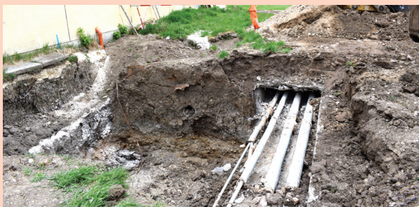
Pätka pre osadenie komína, ktorý bude vysoký 22 metrov
