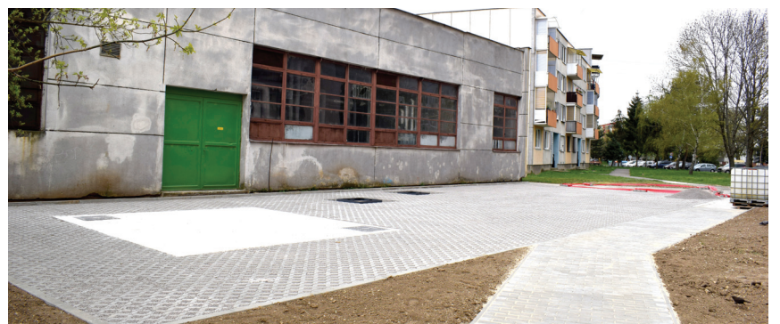
Zrenovovaná spevnená plocha z vegetačnej dlažby určená pre odstavenie 10 osobných áut pri bytovom dome č. 1015 na Veľkej okružnej
